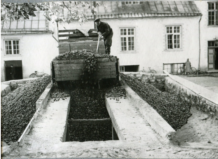
Foto 3. 1960. aasta paiku Viru tänava äärde püstitatud lahtine kartulite vastuvõtmise ja töötlusse toimetamise liin hüdrokanaliga ehk restok.
