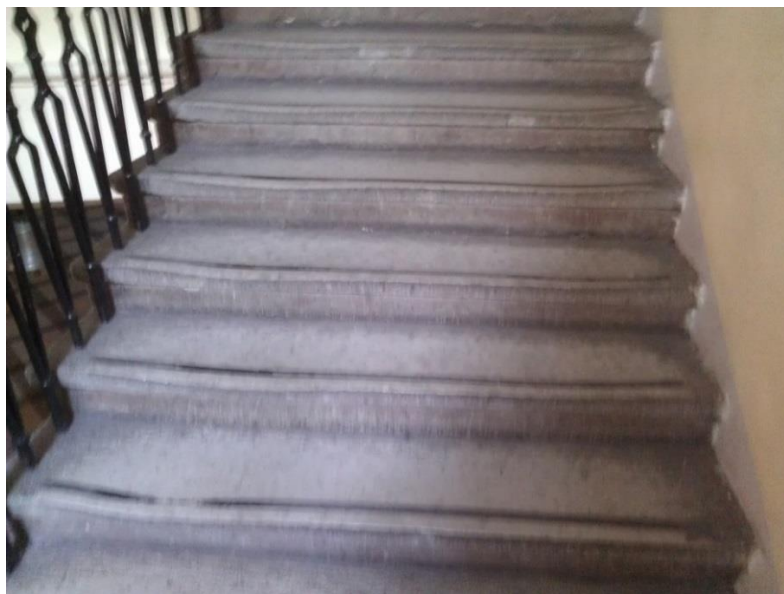
Joonis 6. GAGi peatrepp
