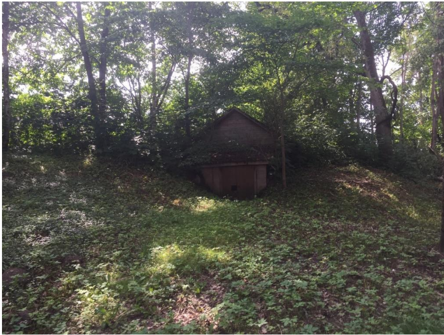
Joonis 18. Mõisateenijate elamu kohal olev kelder
