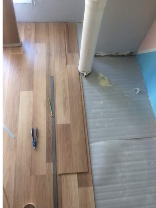
Joonis 13. Laminaatparketi paigaldamine Autor: K. Toom (25.06.2018)
