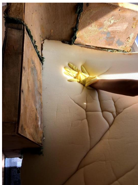
Joonis 17. Uue porolooni sobitamine Autor: K. Toom (7.08.2018)
