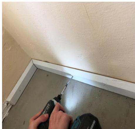
Joonis 4. Liistude eemaldamine Autor: G.L.Uuk (11.06.2018)
