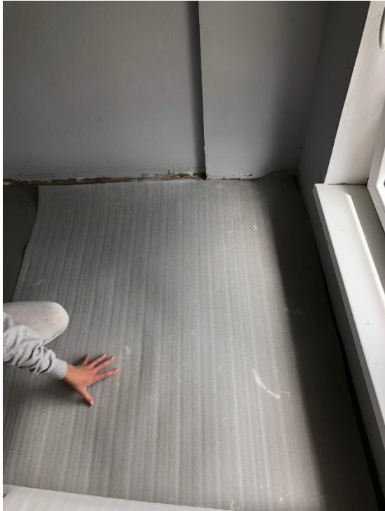
Joonis 12. Laminaatparketi alusmati paigaldamine Autor: K. Toom (25.06.2018)
